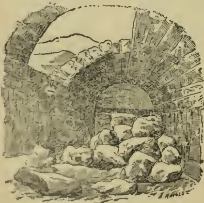
Le puits de Jacob. (État actuel.)
